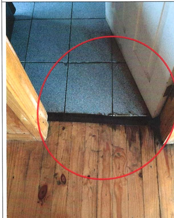
Fotografía N° 3. Cerámicas sueltas debido a problemas de humedad provocado por filtraciones.
